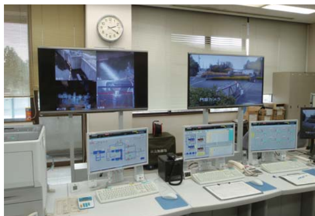
4 茨城県企業局涸沼川浄水場 中央監視制御システム
