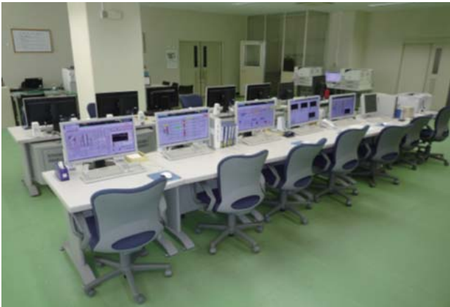
1 名古屋市上下水道局空見スラッジリサイクルセンター 監視制御システム
