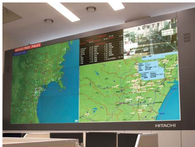
10 宮城県警察本部 通信指令システム 大型表示装置
