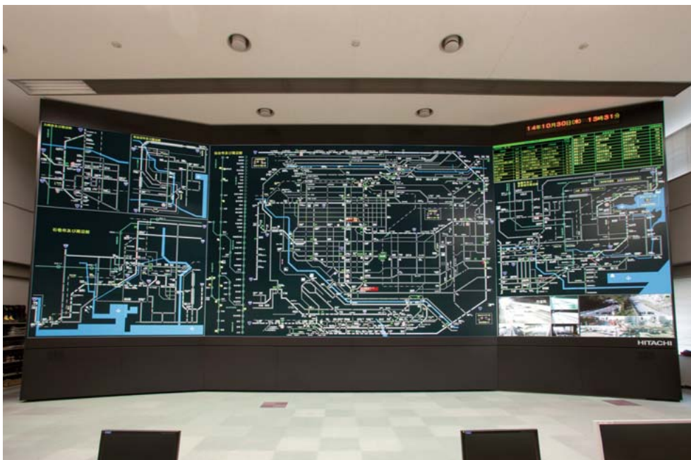
9 宮城県警察本部 交通状況表示板システム
