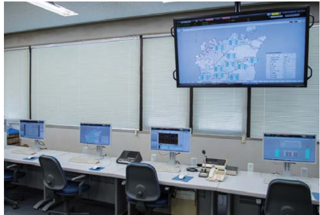
2 新居浜市水道局水道管理センター 水道施設監視システムの中央監視室
