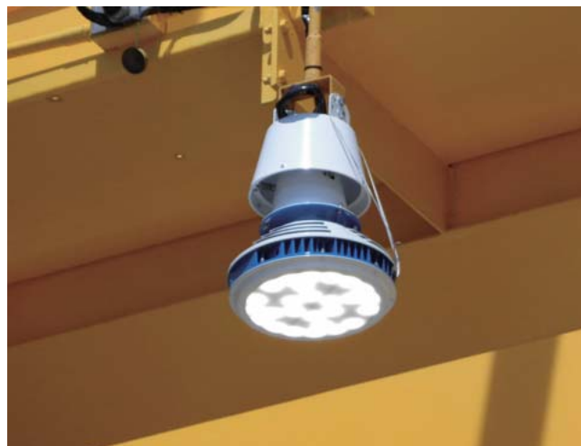
8 工業用LED照明「タフエコライト」のクレーン設置状況の例
