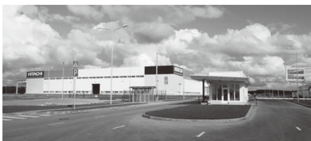
図8 | 工場建屋の外観
