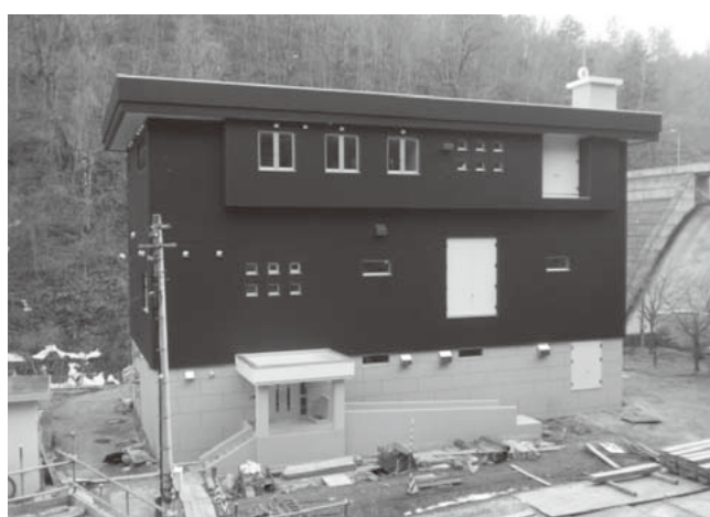
図2 | 建設中の清水沢浄水場（2015年3月）
