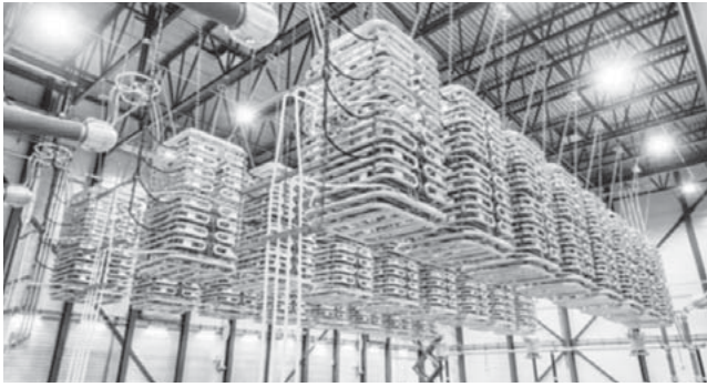
図7 | Skagerrak4プロジェクト(ノルウェー, デンマーク間 700 MW/500 kV) 19)
