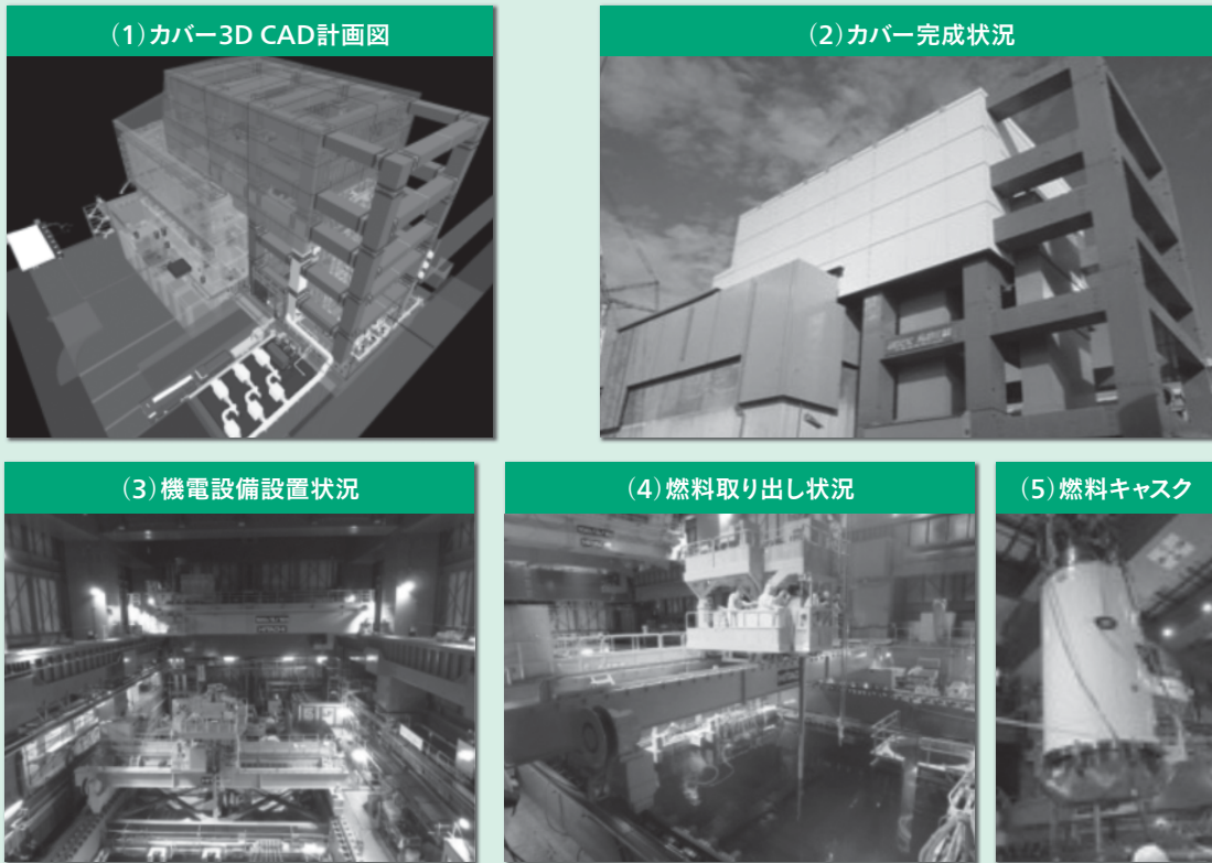
図1 4号機カバーおよび機電設備設置状況
