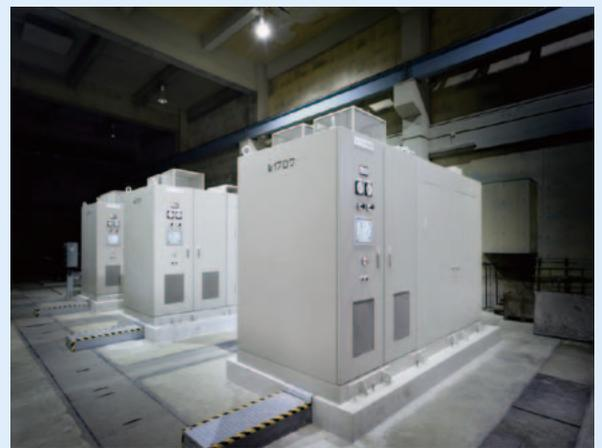
16 磁気軸受搭載高速単段ターボブロワの構造とその外観
