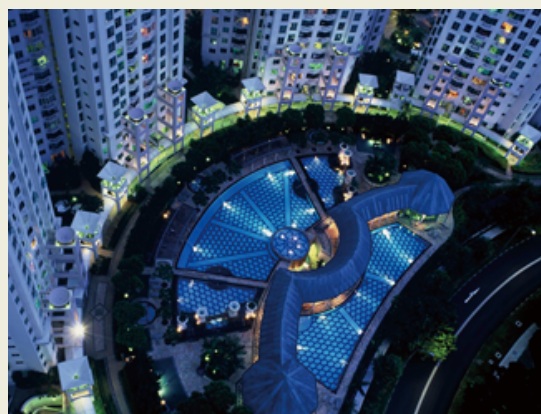
8 噴水設備納入事例(上)、プール設備納入事例(下)
