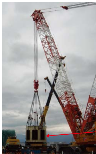
5 東京電力パワーグリッド 新信濃変電所 同期調相機固定子の吊り出し作業
