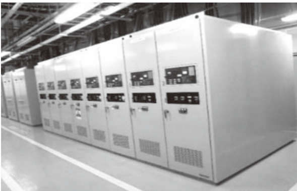
図7| 直流高速度真空遮断器
