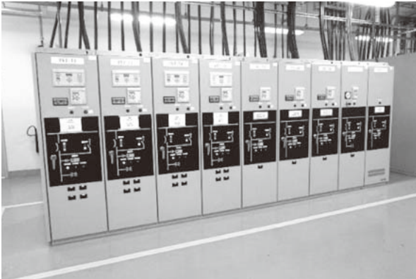
図7| 直流高速度真空遮断器
