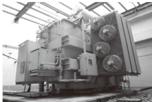
図5 | 35/43.75 MVA主変圧器
