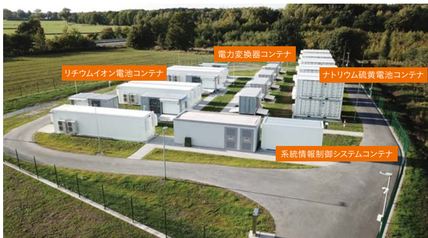
8 実証運転中の大規模ハイブリッド蓄電池システム (出典: NEDO, EWE AG)
