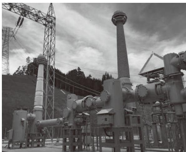
電位の均一化を実現している。さらに、直流システムの保護制御に関して重要な構成要素である直流用変流器はゼロフラックス方式の変流器であり、直流用変成器は抵抗容量分圧方式の変成器である。これらはともに直流専用の新規品であることから、誤差性能に代表される性能評価だけでなく、GISに組み込んだ状態で補助盤を含めた計測システムとして検証を行い、十分な性能・品質であることを確認している。
