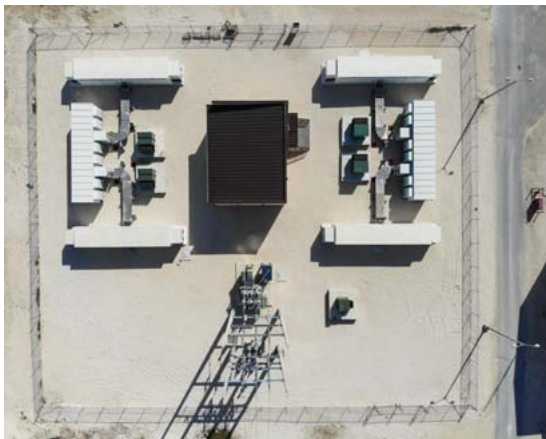
10 グラント・バハマ島のフリーポートにある9.5 MW/7.31 MWh BESS用地
