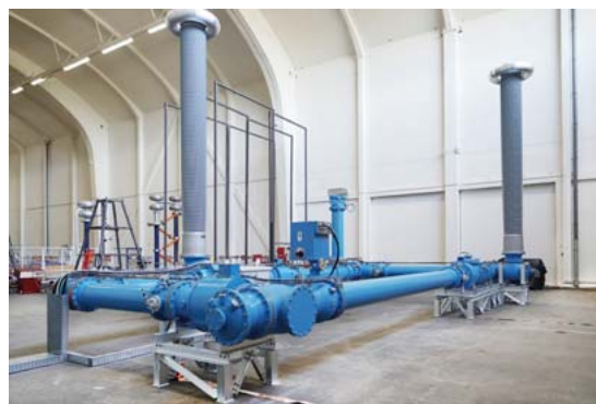
25 設置されたHVDC GISプロトタイプ
