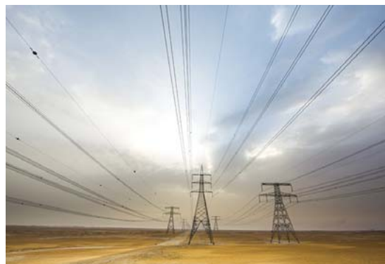
8 400 kV アルダフラススイッチングステーションプロジェクト
