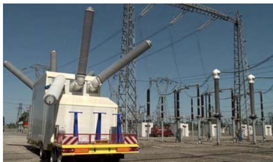
23 災害復旧用のモジュール型移動式変電所
