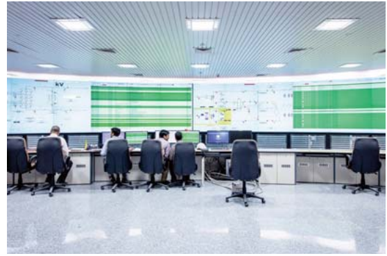
14 北東アーグラHVDC制御室
