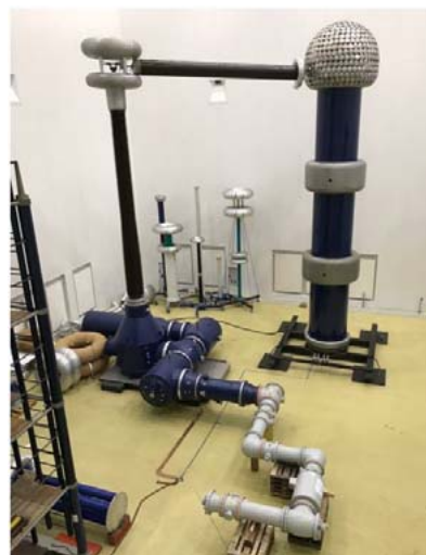
6 高電圧ラボでの420kV受動素子の誘電タイプ試験
