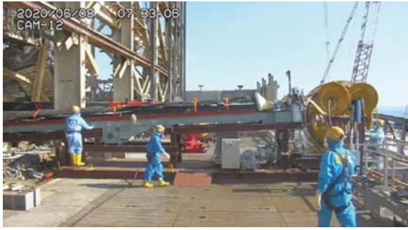
4 養生バグの投入装置状態確認時（左）、エアモルタル充填完了時（右）
