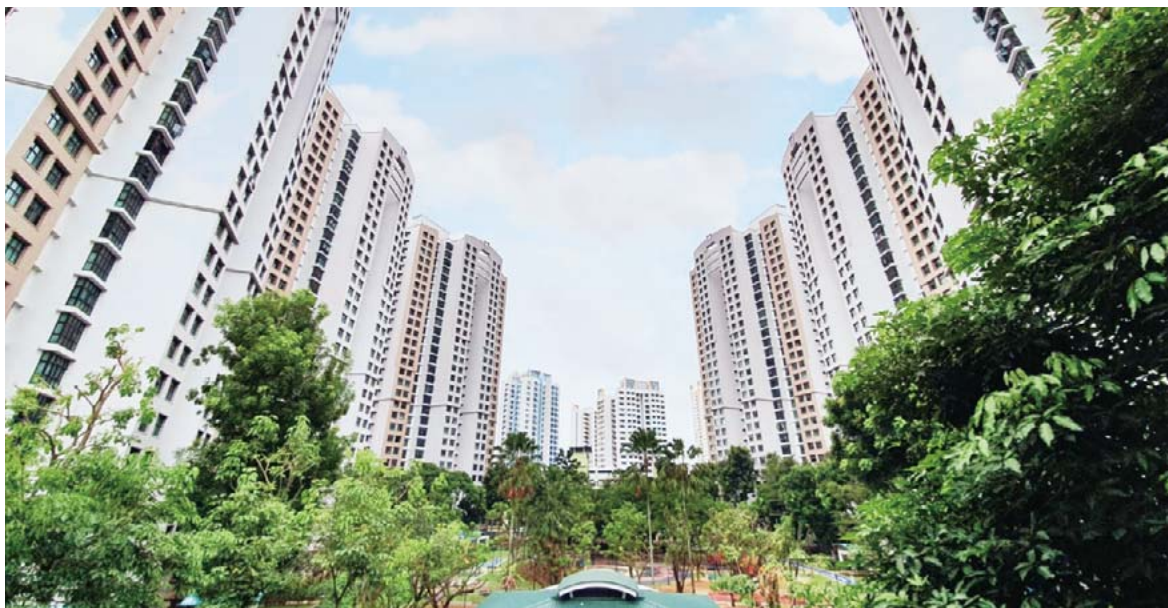
6 シンガポールのHDB地区
