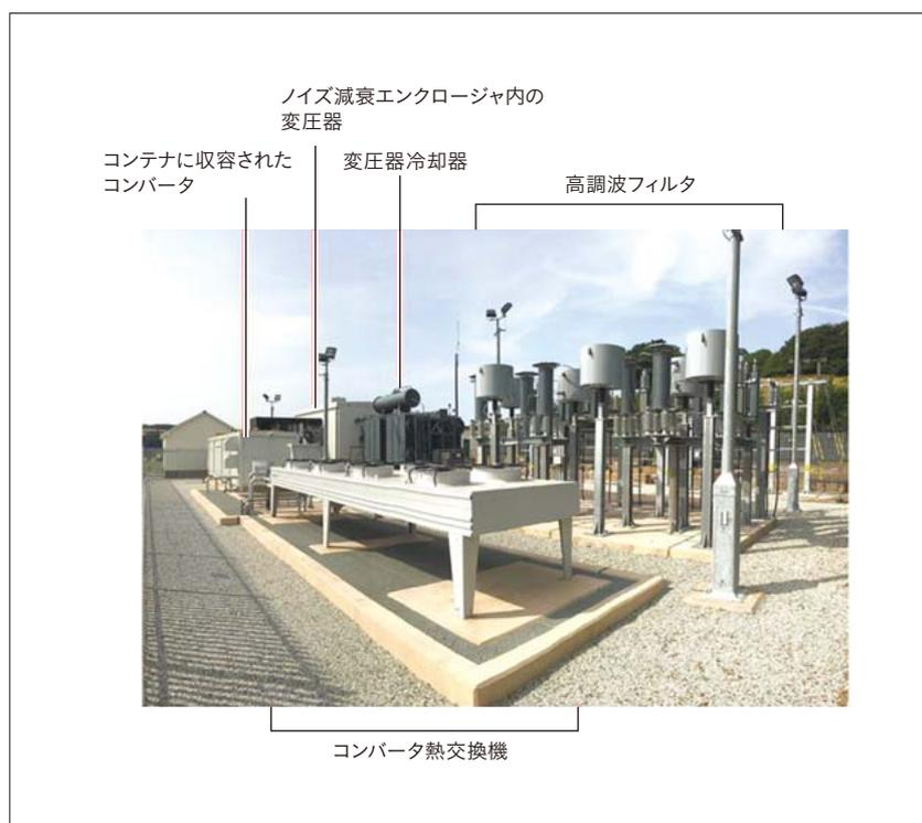
3 柔軟な配電システム (AC-DC-ACコンバータ)
