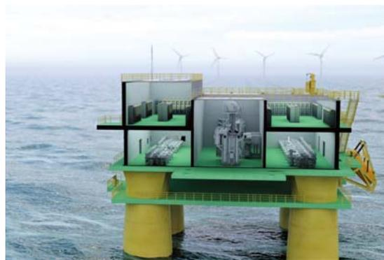
7 洋上風力発電所の浮体式集電変電所の例
