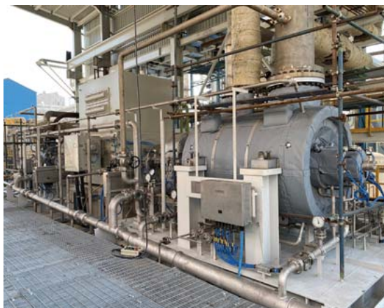
1 7,760 kW電動機駆動CO 2 圧縮機 (左奥：高圧圧縮機，中央：電動機，右手前：低圧圧縮機)
