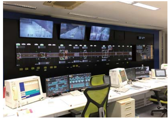
3 つくばエクスプレス運行管理システム運行表示盤および運転指令卓
