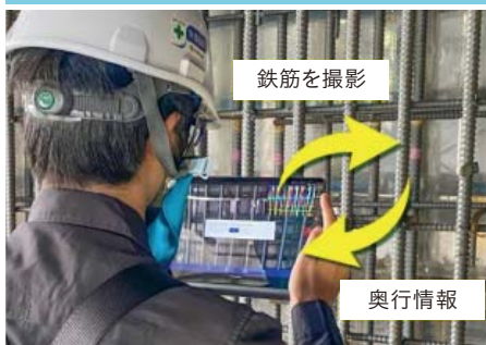
2 GeoMation 鉄筋出来形自動検測システムによる省力化の実現
