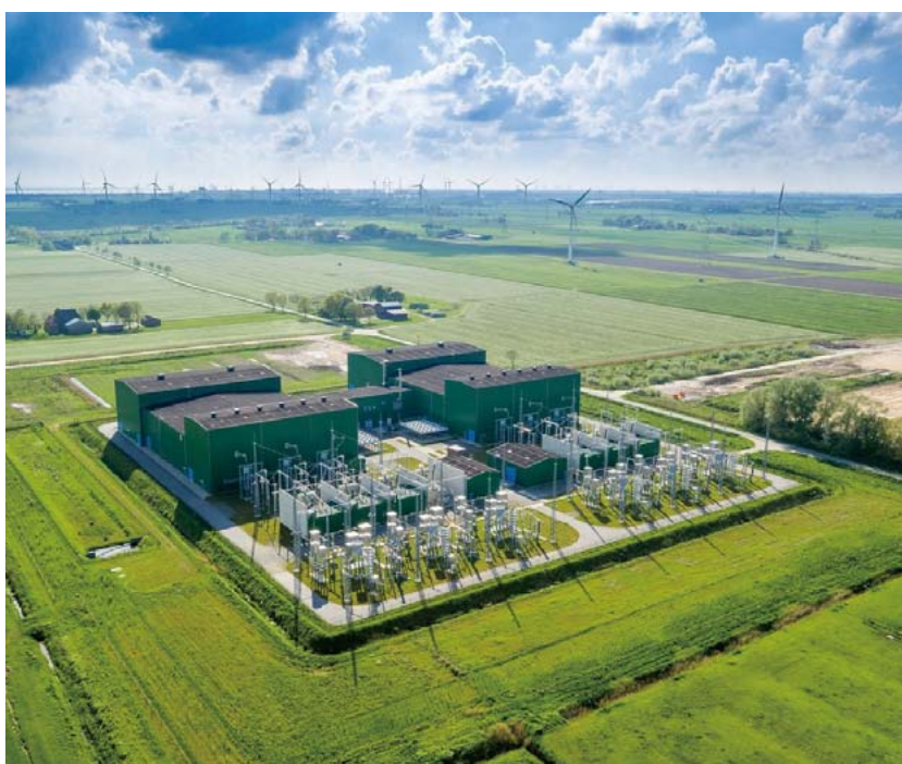
1 NordLink (ドイツ-ノルウェー) Wilster変換所、±525 kV・自動式双極、1,400 MW
