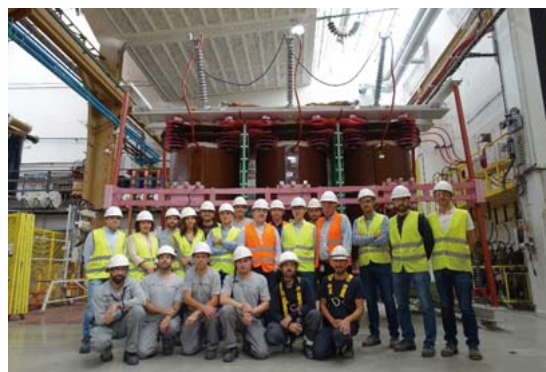
5 顧客工場受入試験を終えた145 kV乾式変圧器
