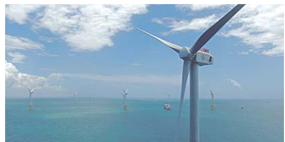
3 台湾洋上に据え付けられた5.2 MW風力発電設備
