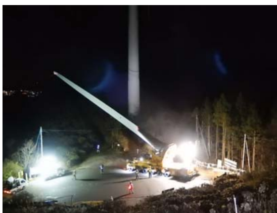
6 ブレード起立台車輸送作業の様子
