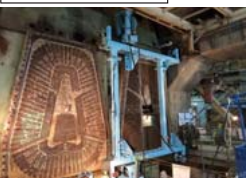
復水器管板切断
