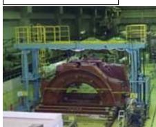
タービン内部車室切断
