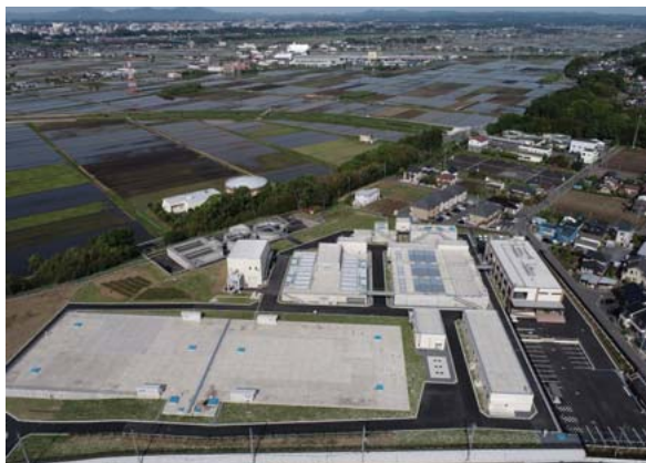
1 上坪浄水場の全景と中央監視室
