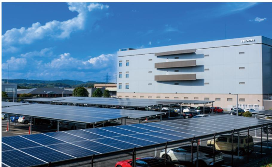
7 データセンター敷地内に設置したカーポートタイプの太陽光発電設備
