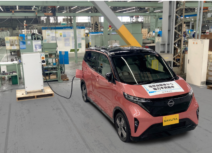
図5 | 日立産機システム習志野工場におけるEVからの給電模様
