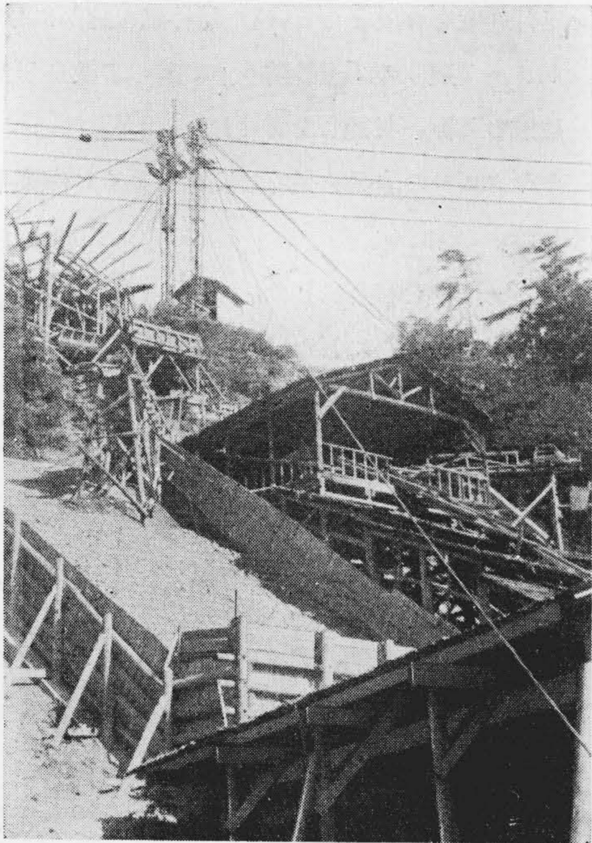
第 10 圖 (a) 1.2 m 3 固定式タワーエキスカベータ 鹿島建設 (新庄ダム用) Fig. 10 (a) 1.2 m 3 Fixed Type Tower Excavator.
