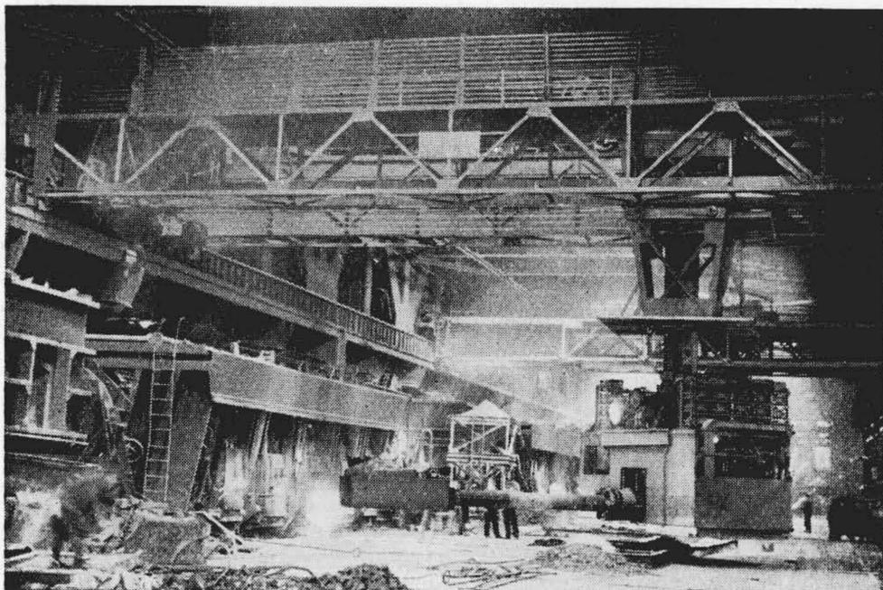
第 4 図 八幡製鉄所納 5t 装入起重機
