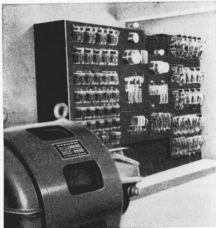
第 31 図 鉄鋼ビル納客用エレベータ (A号、B号機) 用受電盤並びに制御盤
