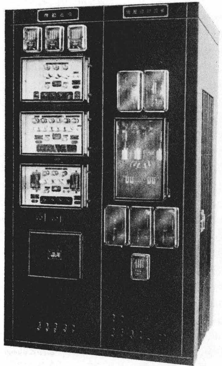
第 4 図 28,500 kVA 水力発電所制御用側面扉付補助配電盤
