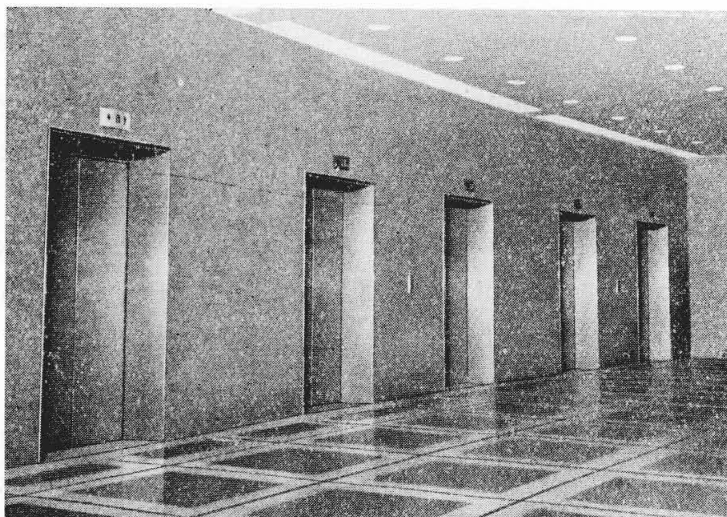
第 1 図 中央開きパネル扉 (日活国際会館エレベータ)
