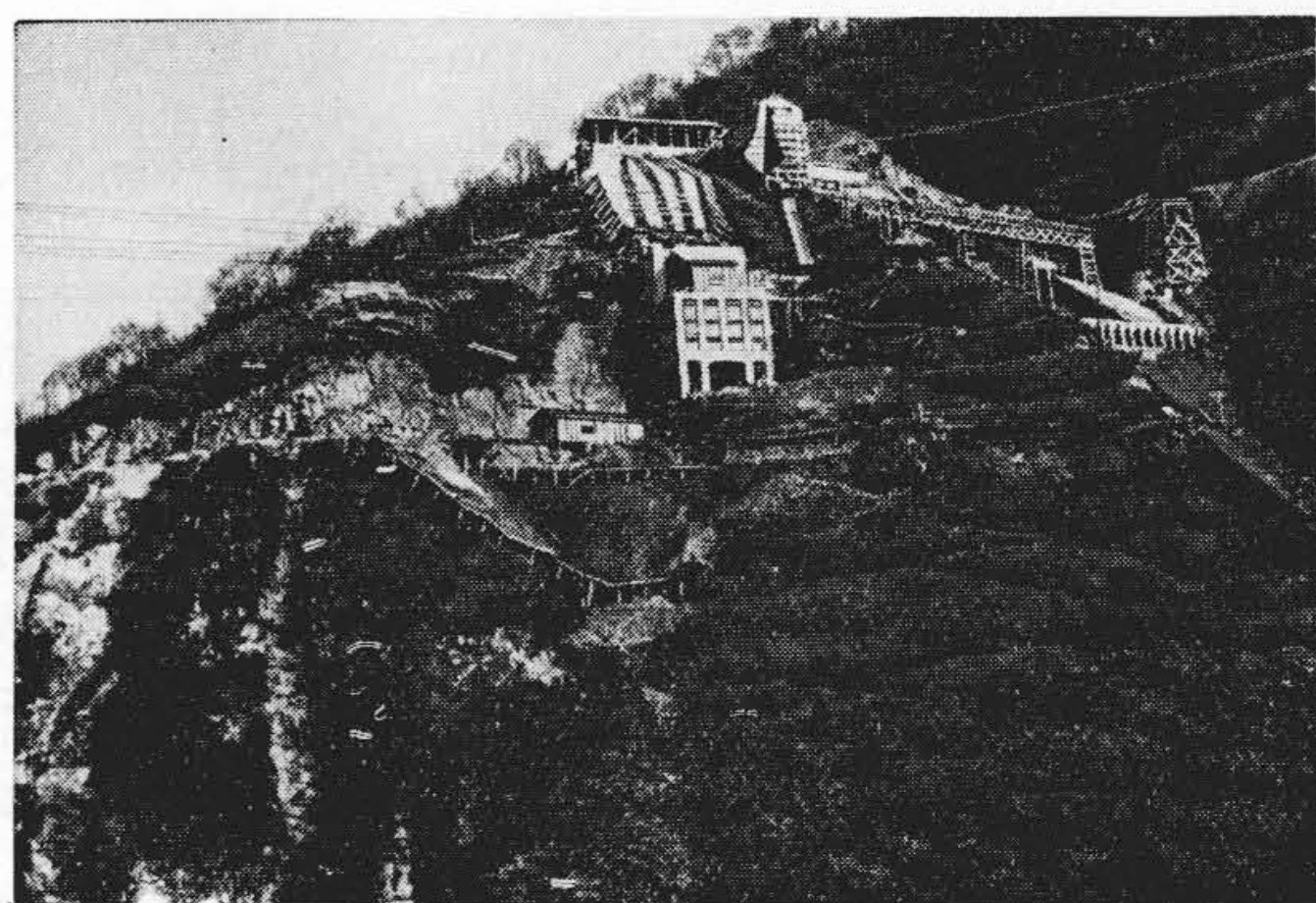
第 29 図-(A) 有峰堰堤のコンクリート設備全景(右岸)
