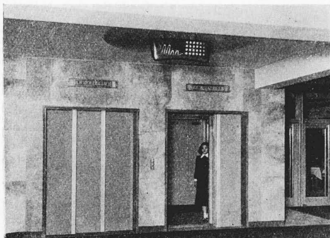
第 31 図 見本市会館納エレベータ Fig. 31. Elevators for Mihon-ichi Building
