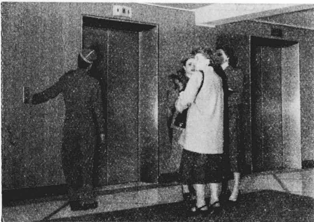
第 28 図 日 活 国 際 会 館 納 エ レ ベ ー タ Fig. 28. Elevators for Nikkatsu International Building
