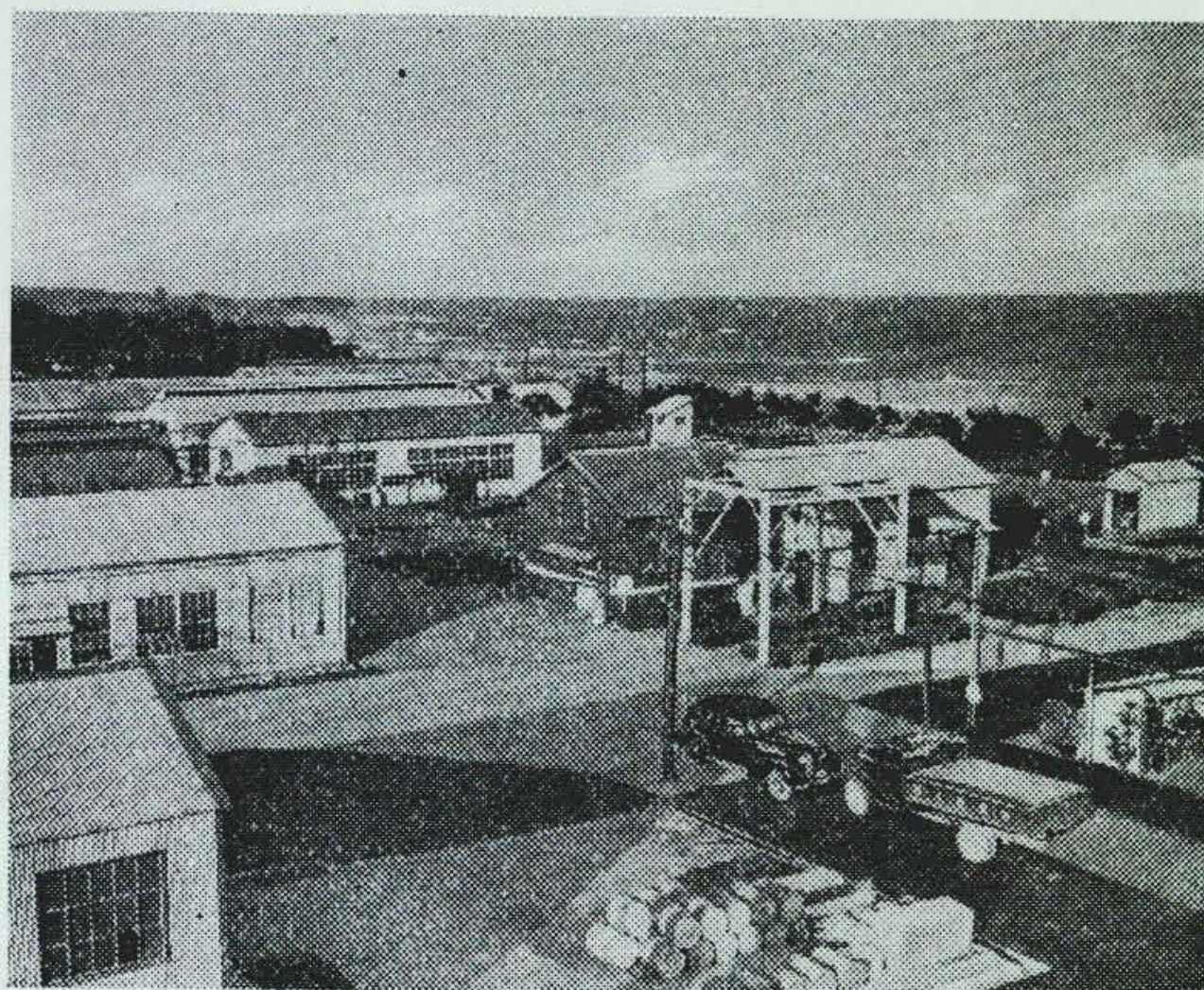
第2図 工場の一部 Fig. 2. A Corner of the Insulating Material Works
