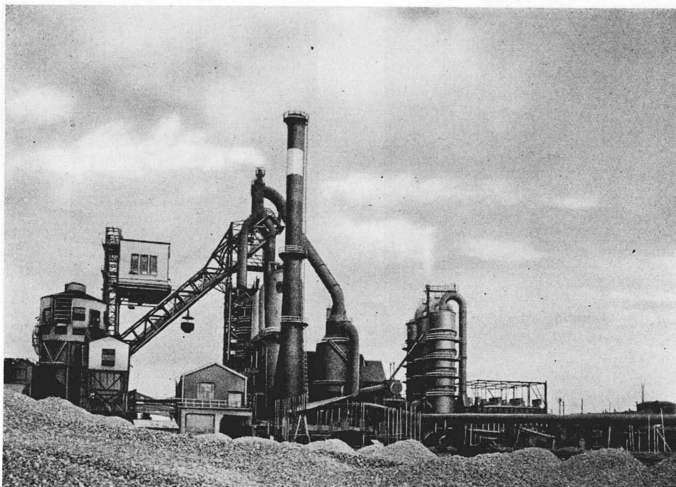
第 17 図 高炉及び高炉巻上機全景
