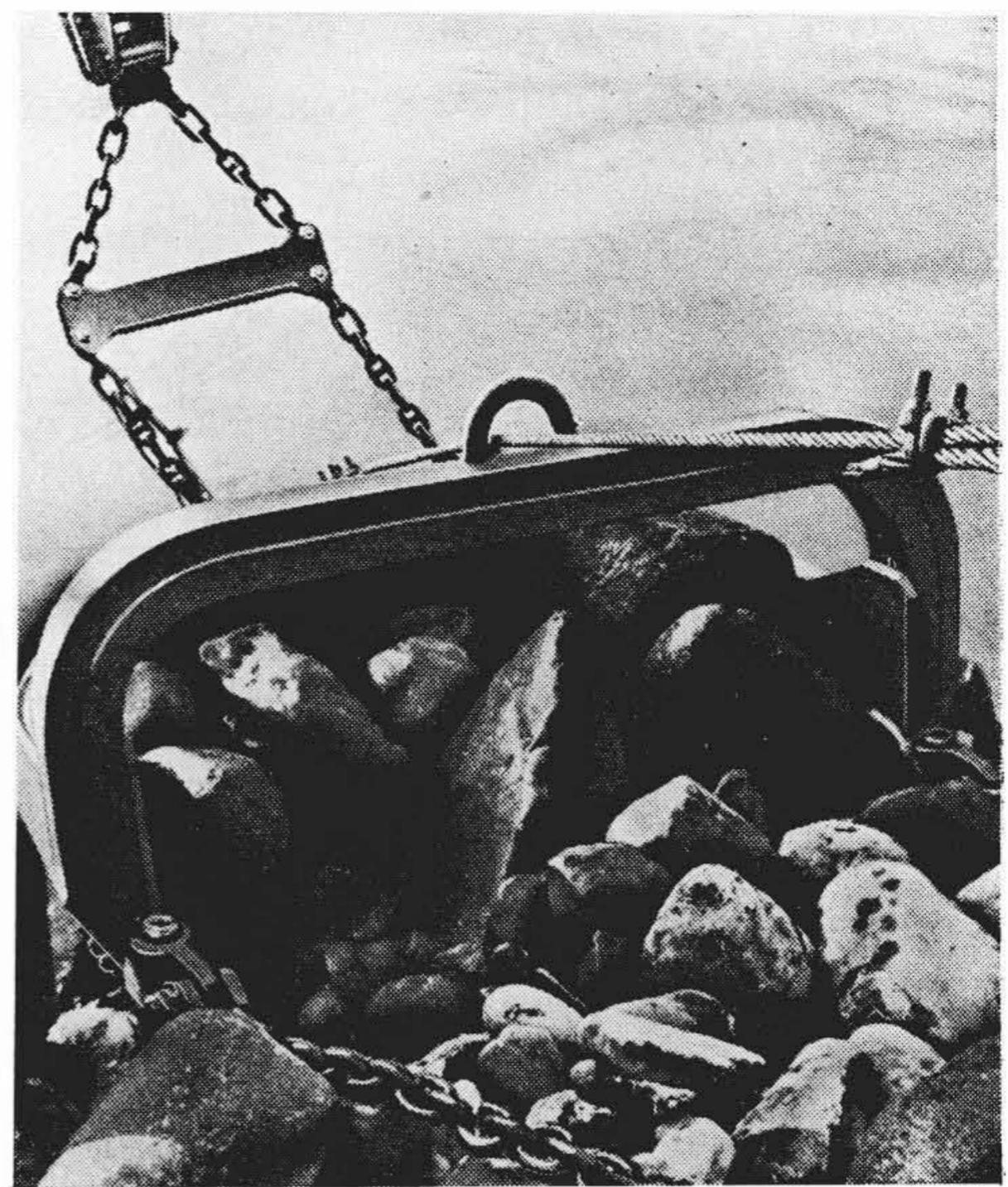
第13図 超重掘削型スクレーパパケット
