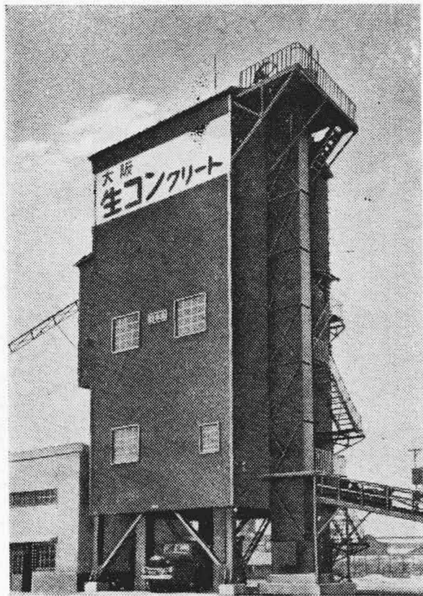
第21図 45 m 3 /hr ミキシングプラント Fig. 21. 45 m 3 /hr Concrete Mixing Plant
