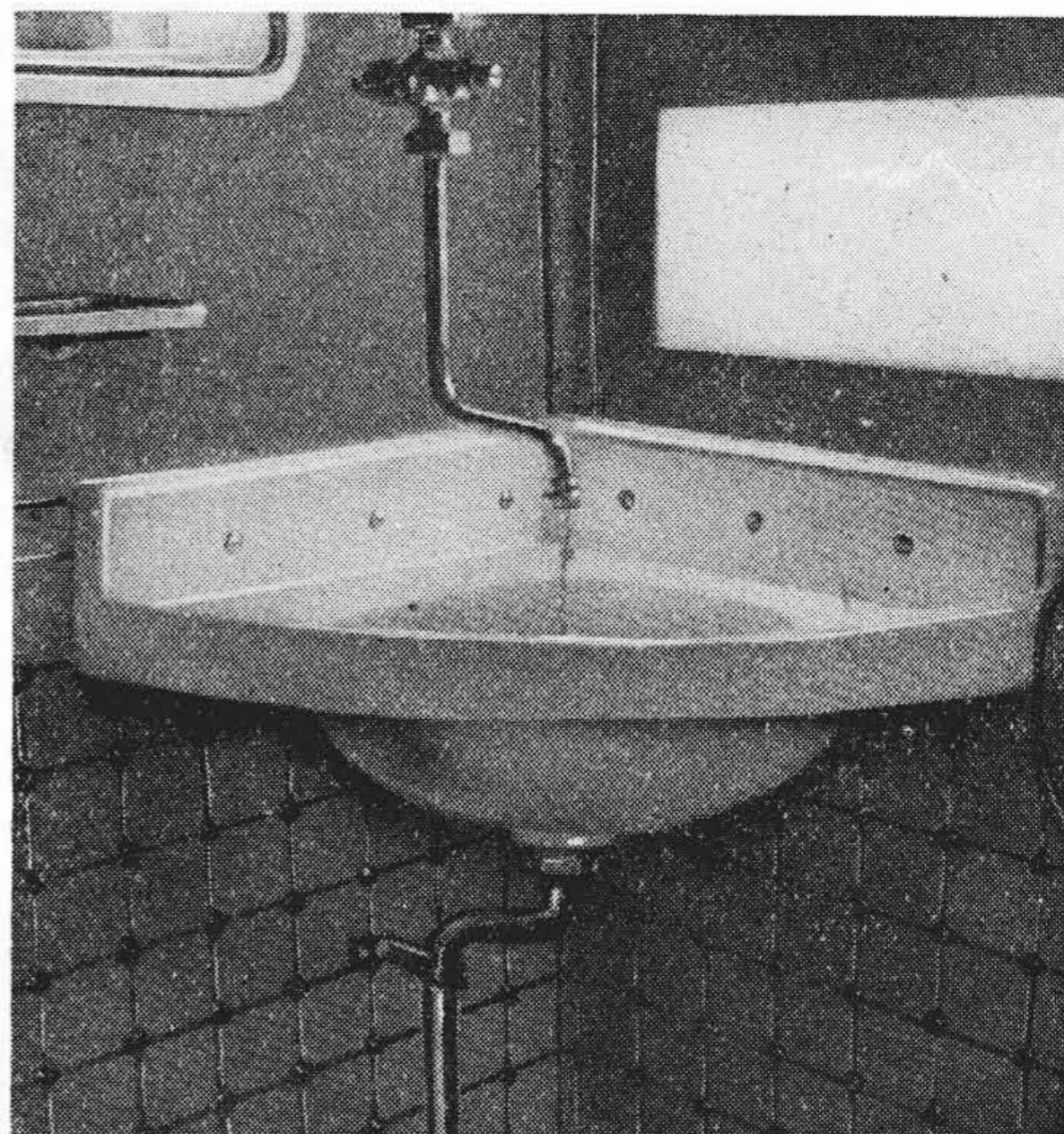
第8図 1等室洗面所(その1) Fig.8. Toilet Room of the First Class Compartment
