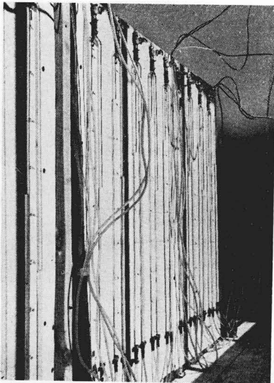
第7図 測定用マノメータ Fig.7. Manometers of Pitot Tubes
