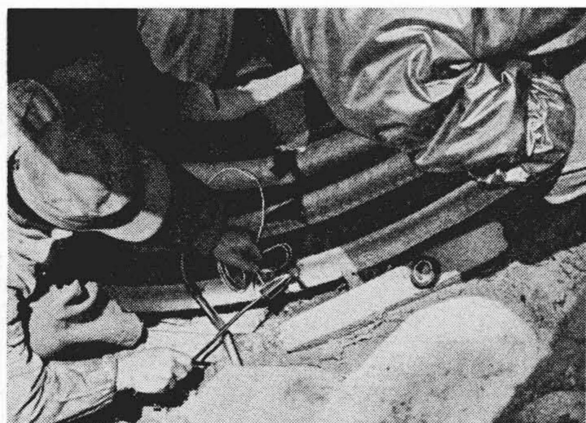
第13図 熱電体取り付け作業
