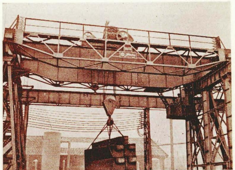
第10図 50 t/10 t 低速型天井クレーン
