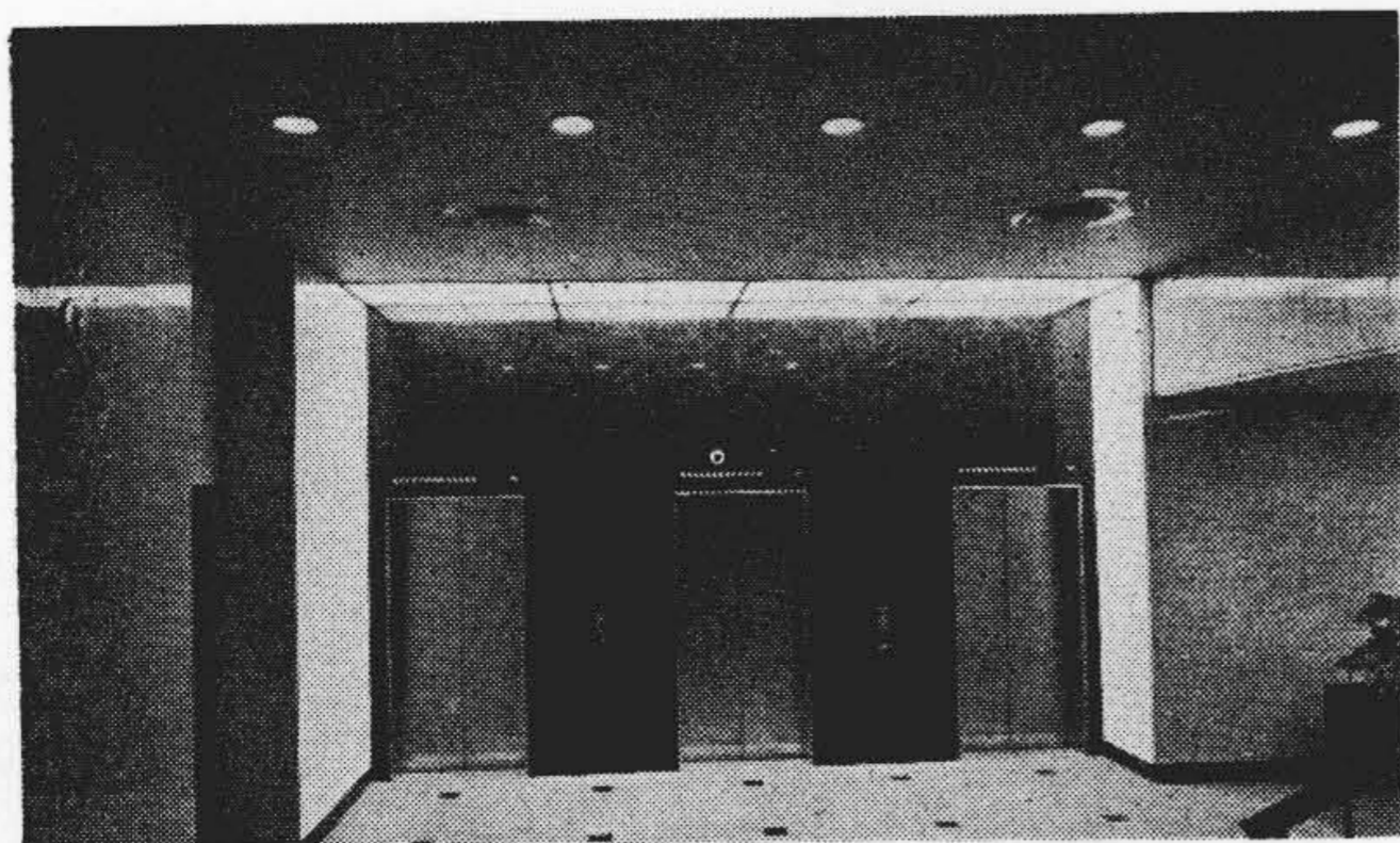
第15図 三和銀行本店納蛍光照明器具 Fig.15. Fluorescent Lighting Fixtures Installed in Sanwa Bank, Ōsaka
