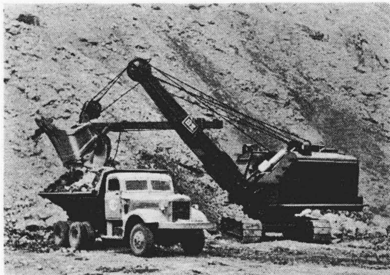
第4図 U16 ショベル Fig.4. U16 Shovel
