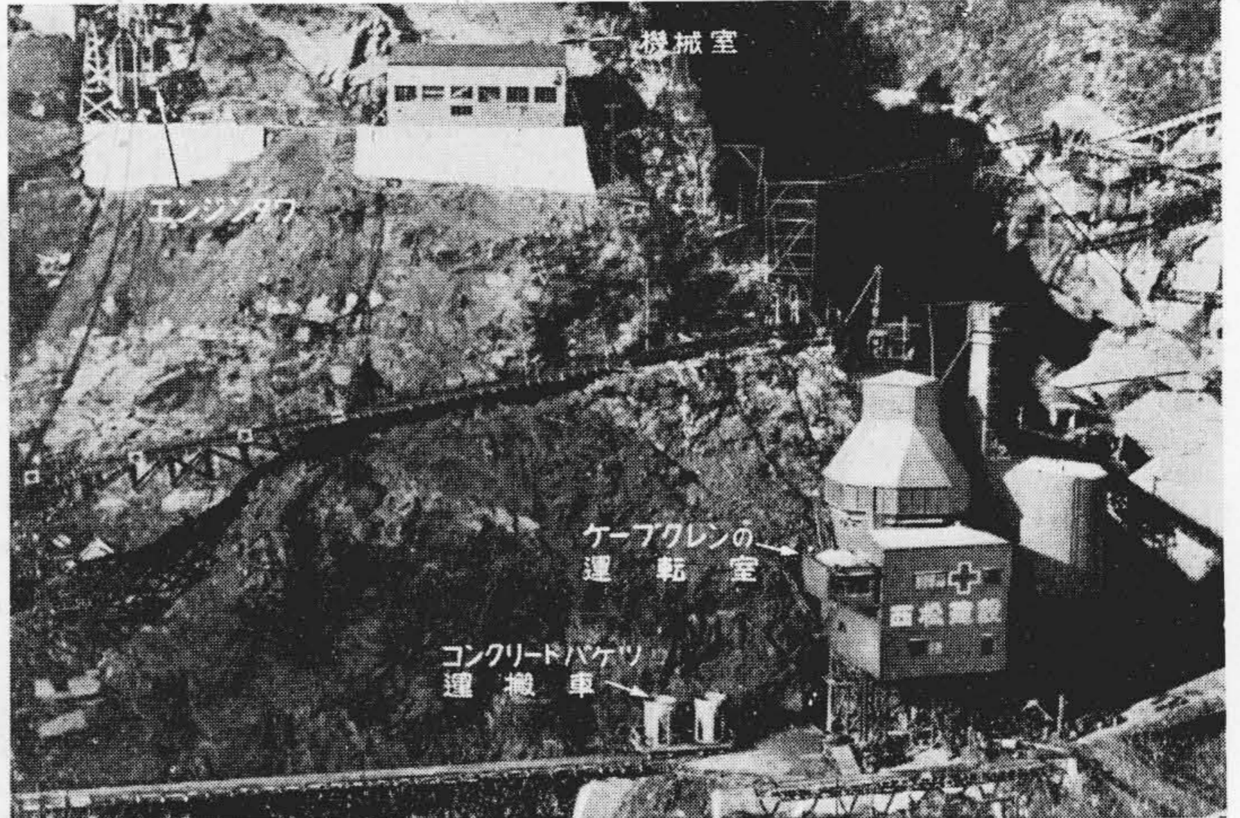
第8図 宮川ダムの 13.5 t ケーブルクレーンエンジンタワー側 (運転室はバッチャプラント3階に設置)
