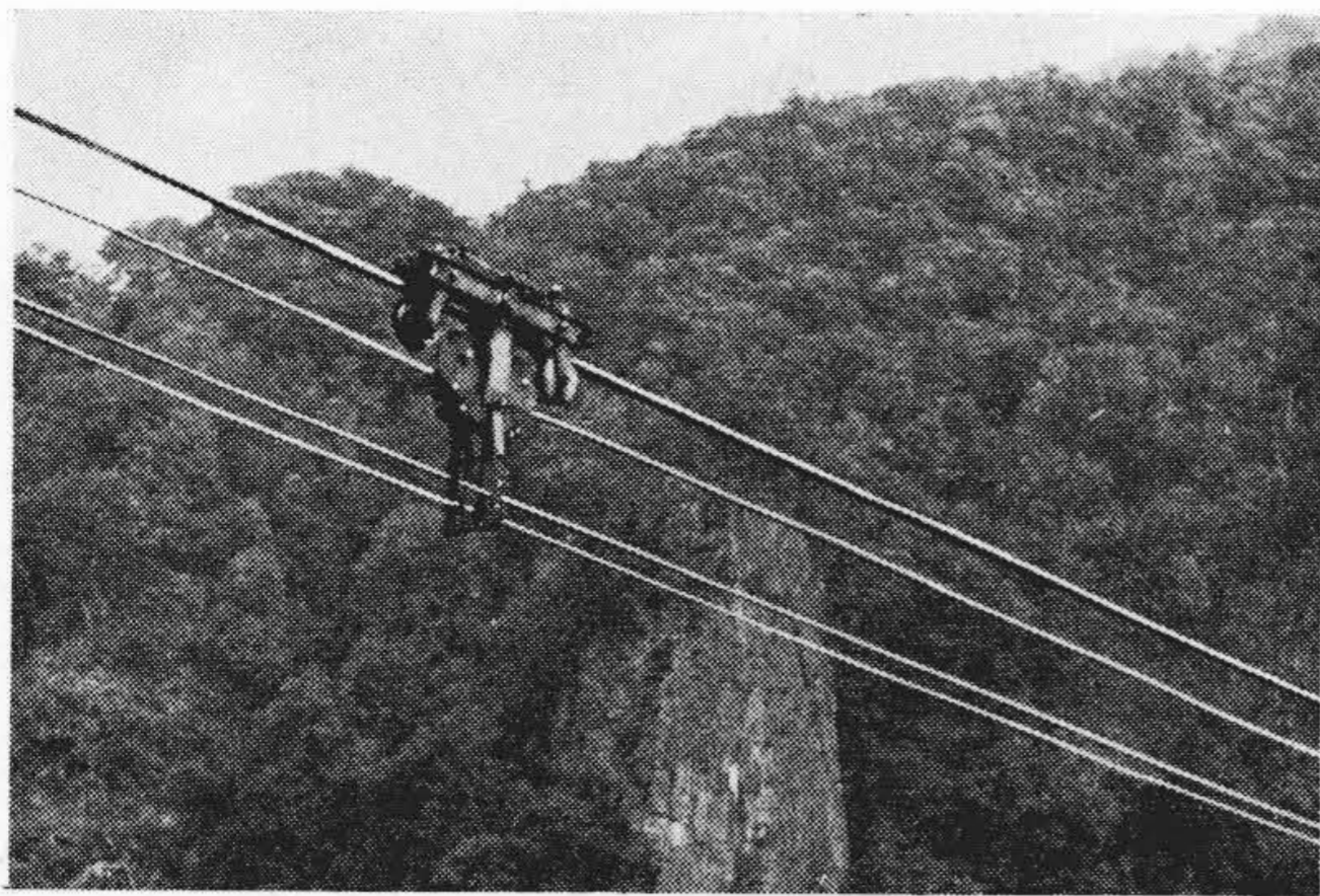
第5図 フリクション式無衝撃キヤリヤ(藤原ダム) Fig.5. Friction Type Shockless Carrier at the Fujiwara Dam
