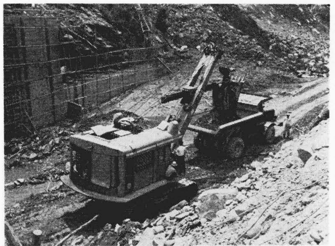
第1図 秋葉ダムで作業中の日立 U12 ショベル Fig.1. Hitachi U12 Shovel in Digging Service at Akiba Dam
