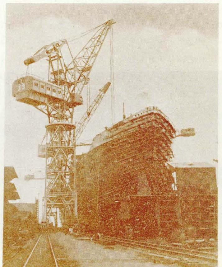
第 4 図 80 t 塔形水平引込クレーン
