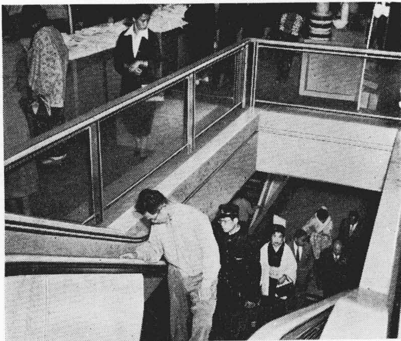
第9図 上野松坂屋納防火シャッター壁を透明とせる欄干
