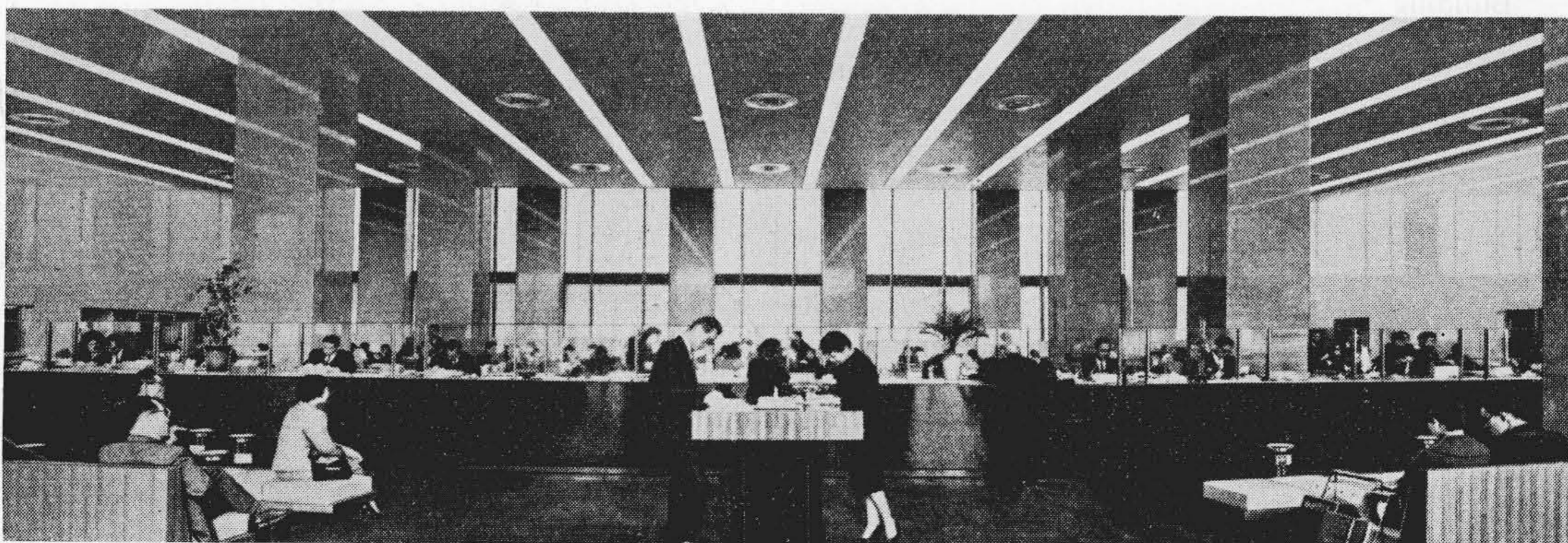
第9図 銀行営業室の照明 (40W 3灯埋込器具×25連×14列) Fig. 9. Fluorescent Lighting for the Bank Hall
