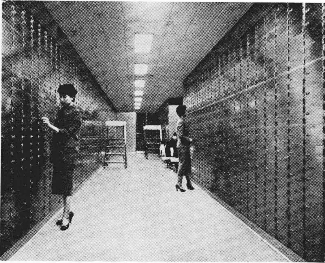
第10図 銀行書庫の照明 (40W 3灯 プラスチックカバー付埋込器具)
