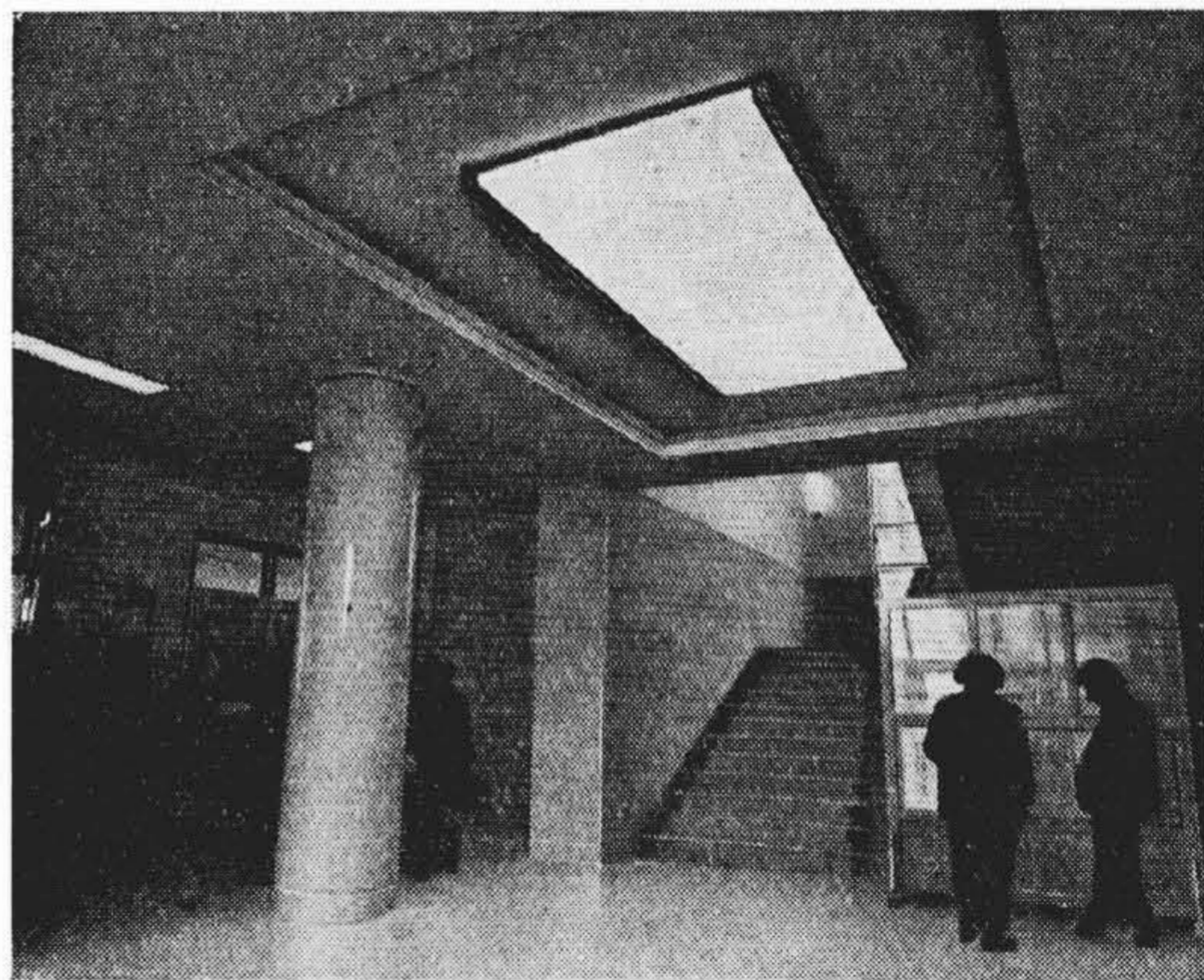
第4図 入口ホールの蛍光灯照明 (40W 16灯 プラスチックカバー付埋込器具)
