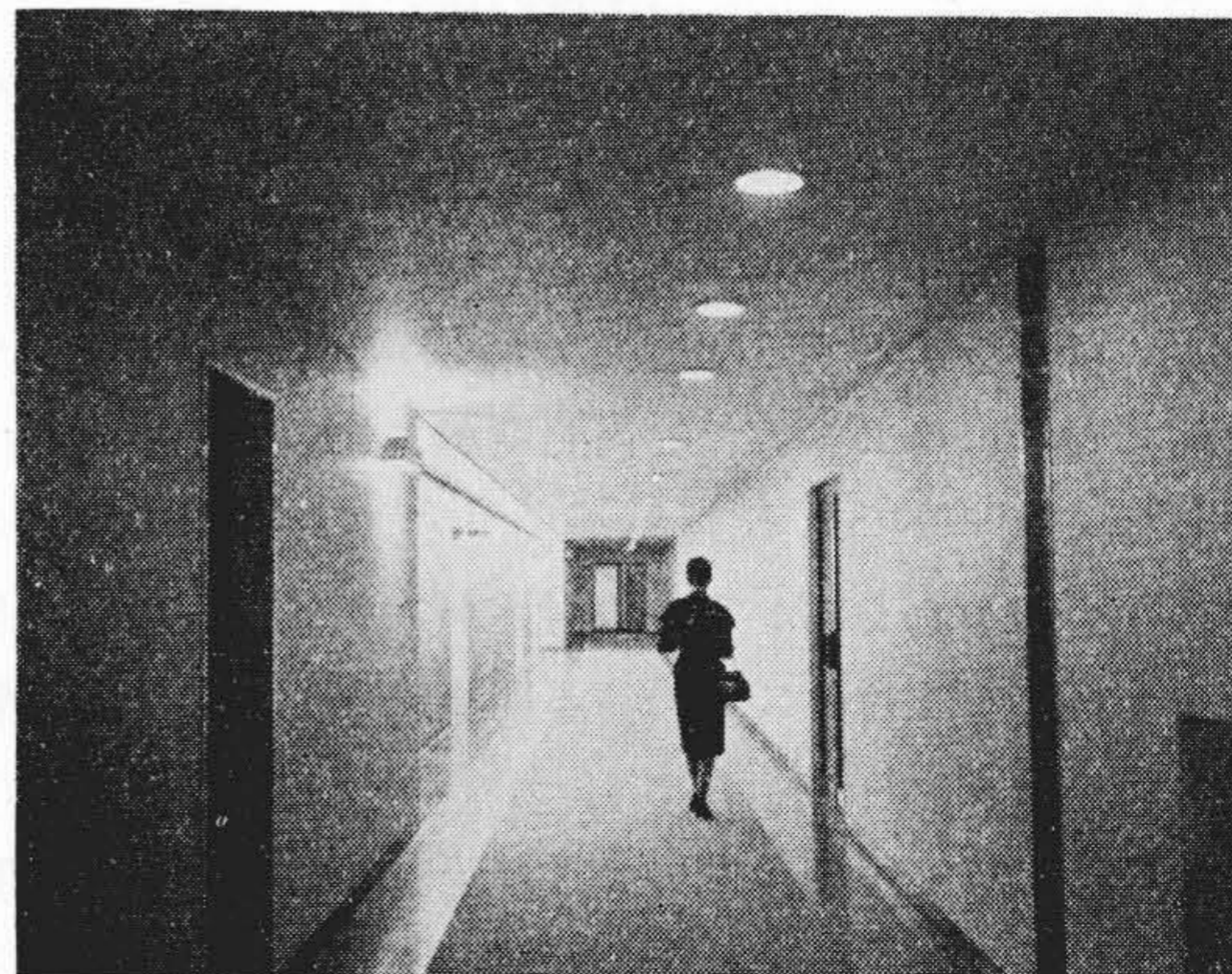
第5図 ダウンライトと連続埋込器具による廊下の照明
