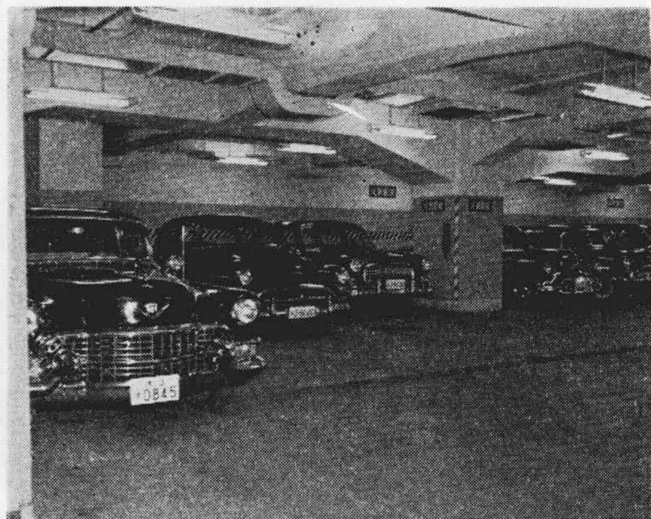
第8図 地階ガレージの40W 2灯露出型蛍光灯器具による照明 Fig. 8. Fluorescent Lighting for the Garage of Under Ground Floor in Building
