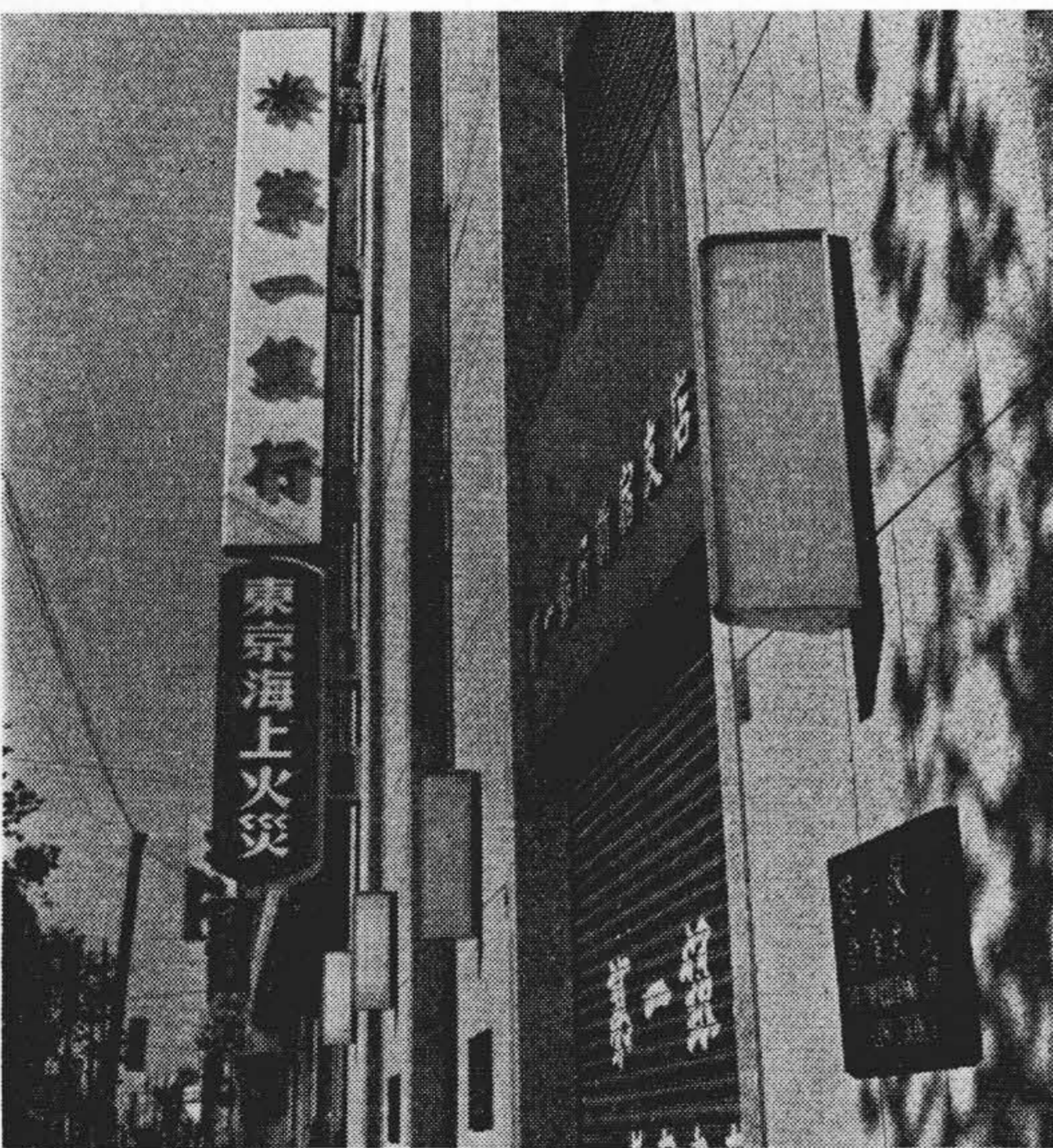
第11図 銀行外壁のブラケット照明 (20W 3灯防湿型ブラケット)
