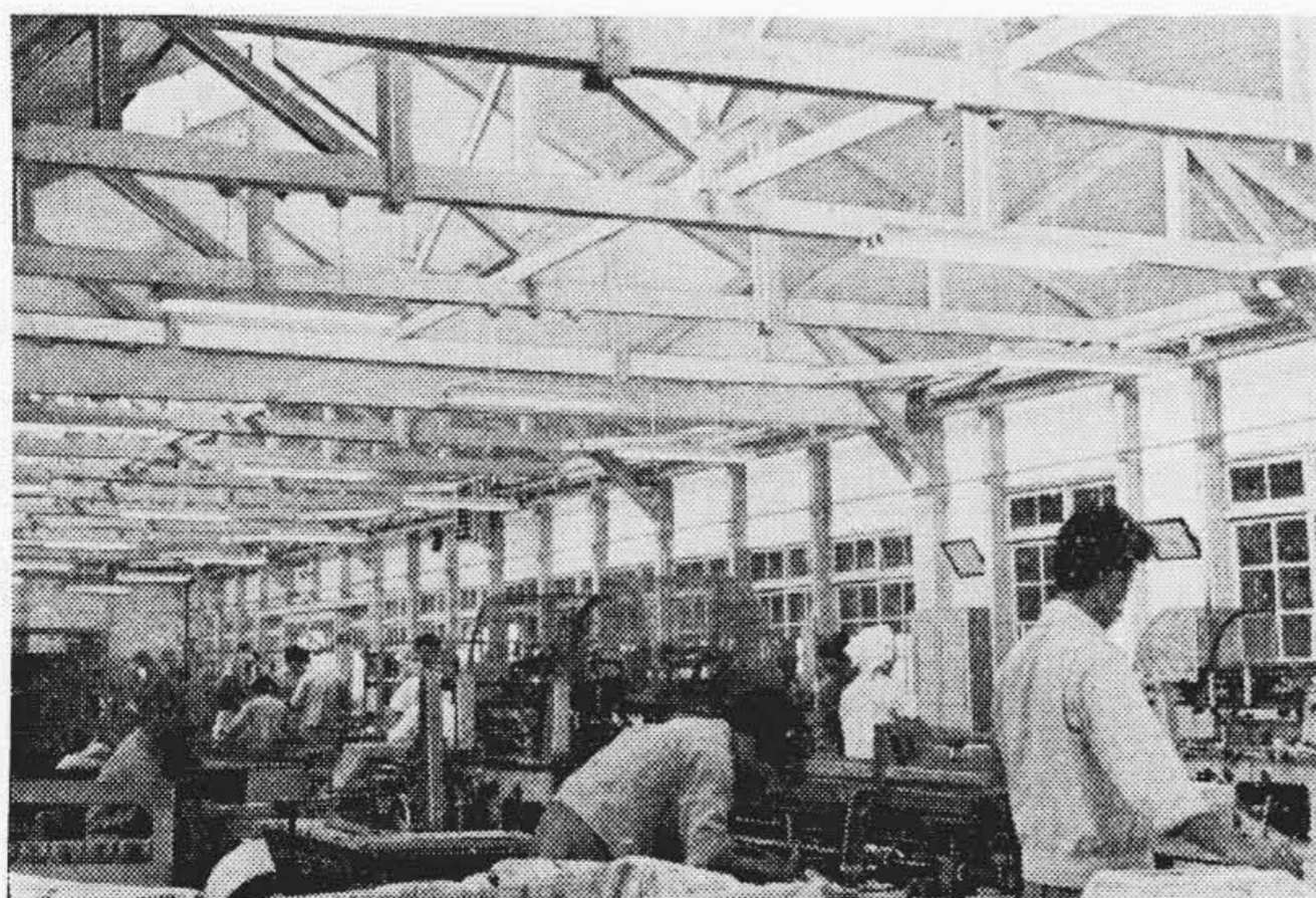
第13図 日本専売公社工場の40W 2灯笠付蛍光灯器具による全般照明 Fig. 13. General Lighting of Fluorescent Lamp for the Odawara Works of Japan Monopoly Corporation
