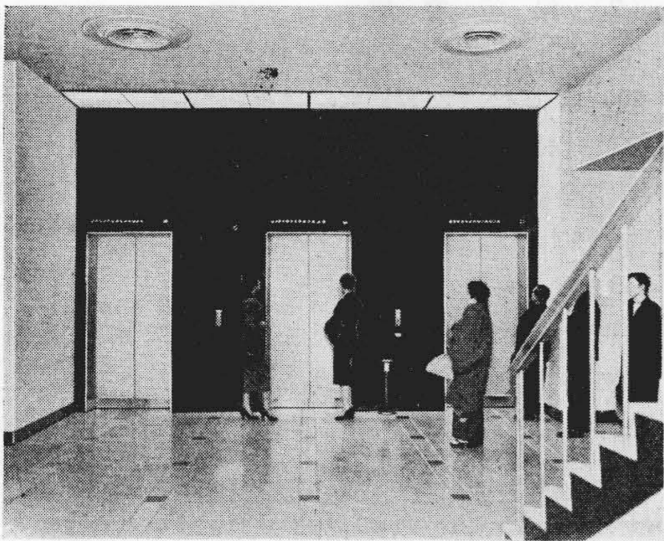
第6図 エレベータホールの蛍光灯照明 Fig. 6. Fluorescent Lighting for the Elevator Hall
