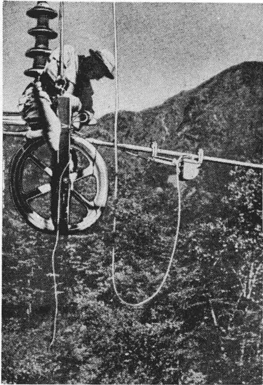
第 10 図 クリノメータによる弛角の測定
