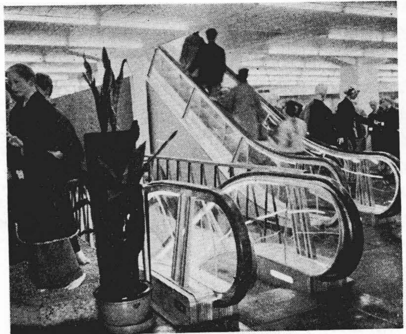
第5図 相模鉄道株式会社相模文化会館納800T型全透明式日立エスカレーター
