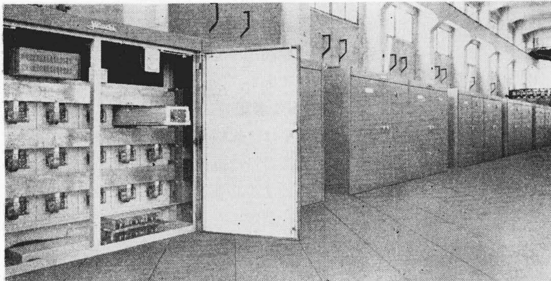
第 1 図 140V 100,000A ゲルマニウム整流器
