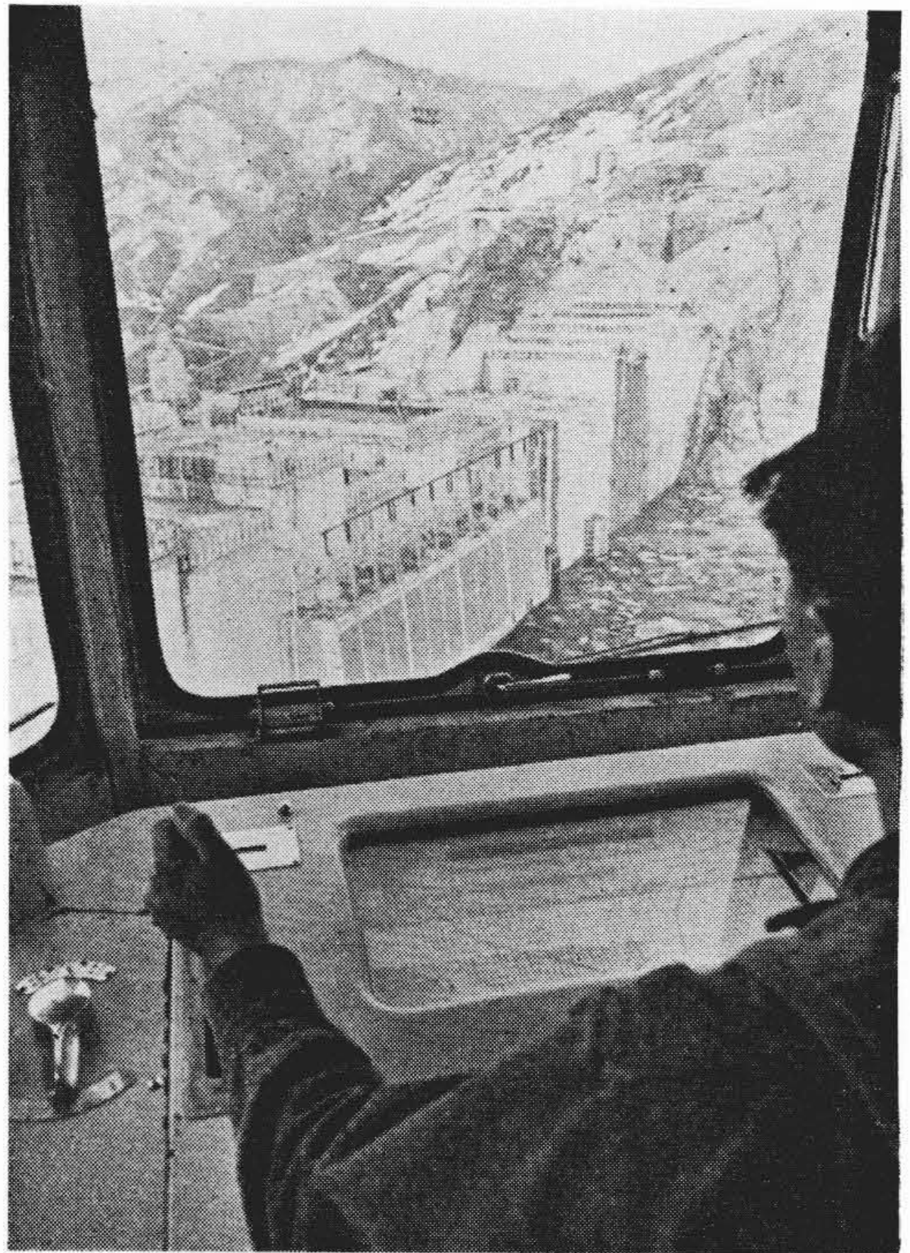
第14図 ケーブルクレーンの機外運転室 (朝日新聞朝日ジャーナル提供)
