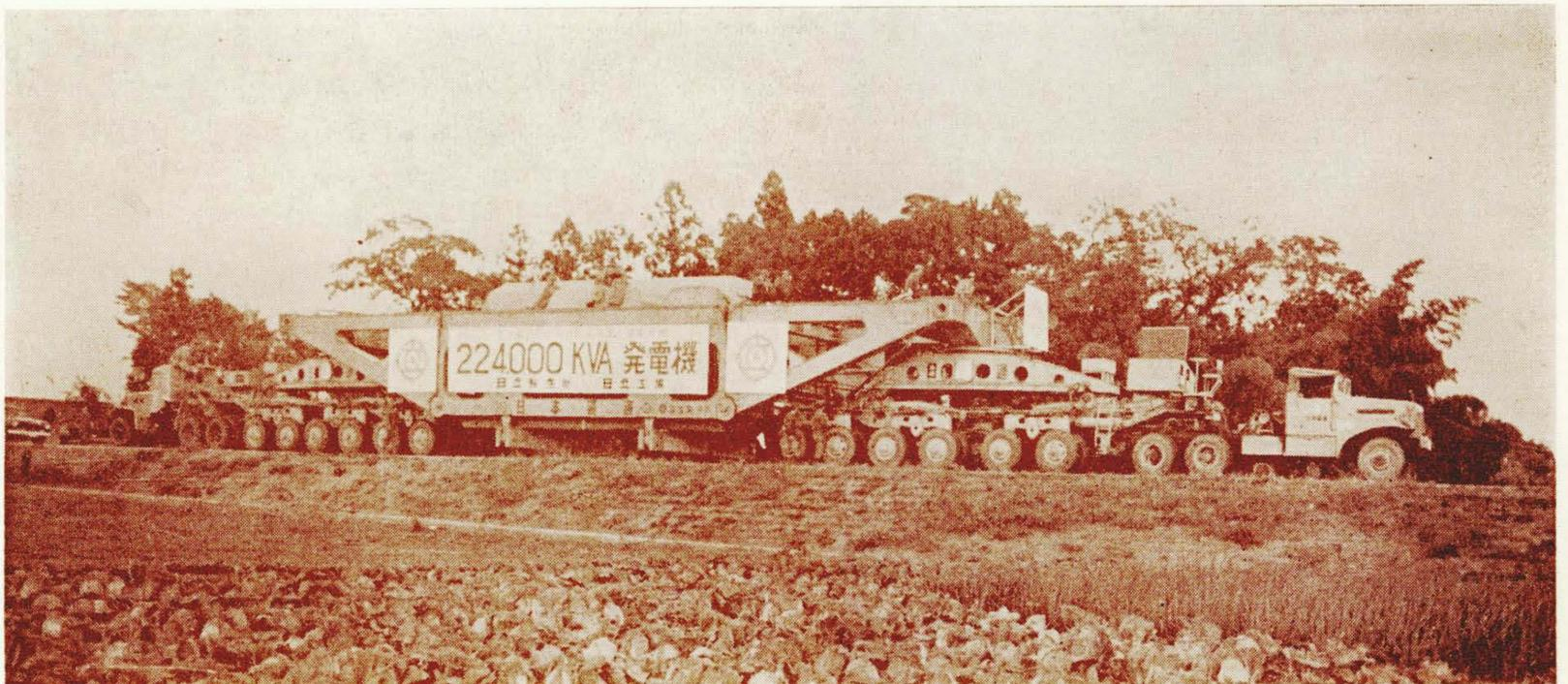
第2図 300 t積トレーラによって輸送中の 224,000 kVA タービン発電機固定子
