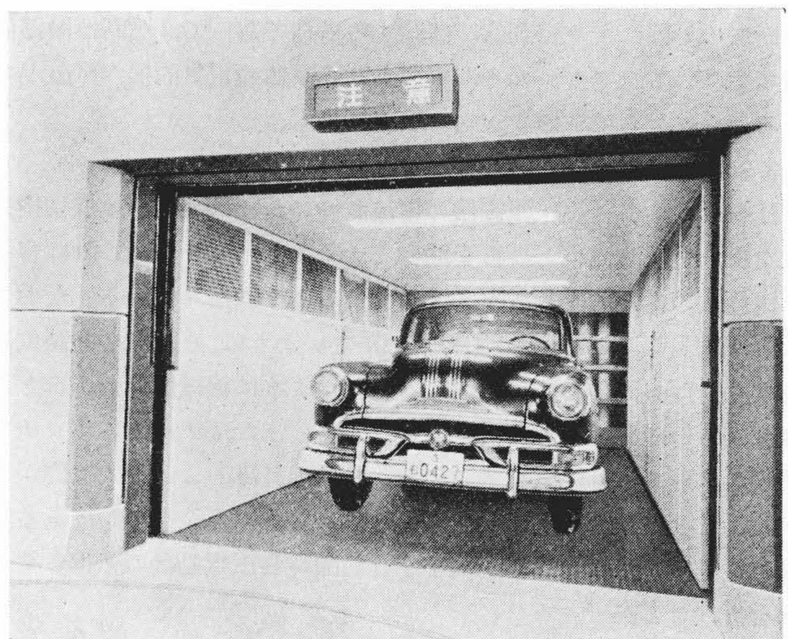
第1図 古河鋳業ビル納油圧式自動車用エレベータ
